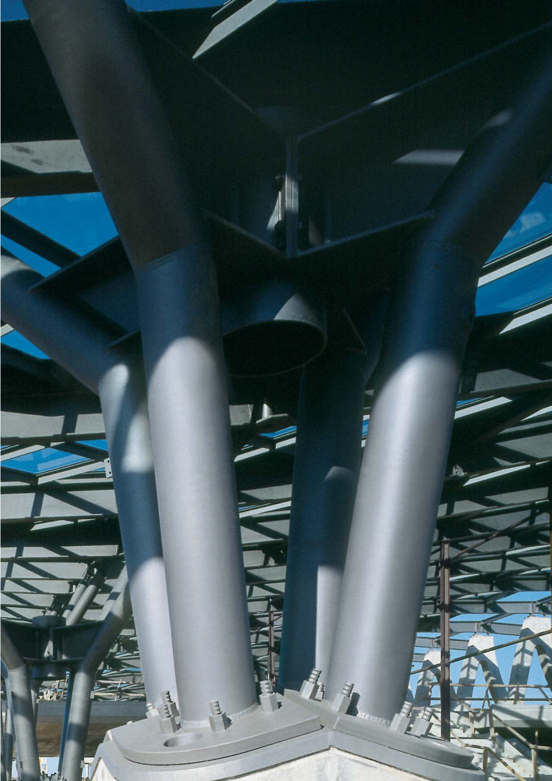
Kontur- und Gehrungsschnitte inklusive Schweißnahtvorbereitung
